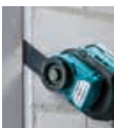
Corte de masilla de ventanas, silicona.
