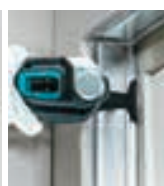
Retirada del marco de ventanas.
