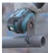
Corte de tubos de PVC.
