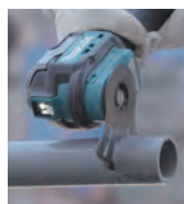
Corte de tubos de PVC.
