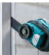
Corte de masilla de ventanas, silicona.
