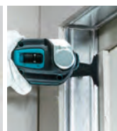
Retirada del marco de ventanas.
