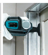
Retirada del marco de ventanas.
