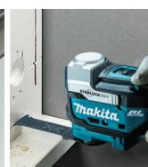
Trabajos de apertura de puertas.
