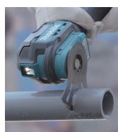
Corte de tubos de PVC.
