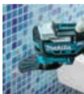
Encaje de juntas en revestimiento cerámico.
