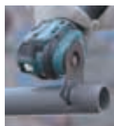
Corte de tubos de PVC.
