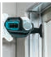
Retirada del marco de ventanas.
